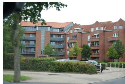
Geschosswohnungsbau im Neuen Zentrum
